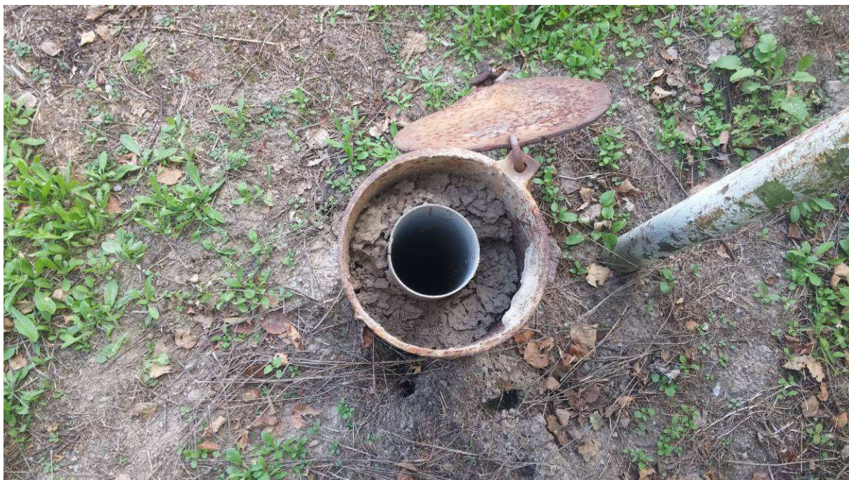
Pohled od otevřené stávající drenážní studny, která bude pročištěna tlakovou vodou. Patrné ocelové potrubí DN 200 s vnitřním perforovaným potrubím PVC DN 90 s výplní propustnou zeminou
